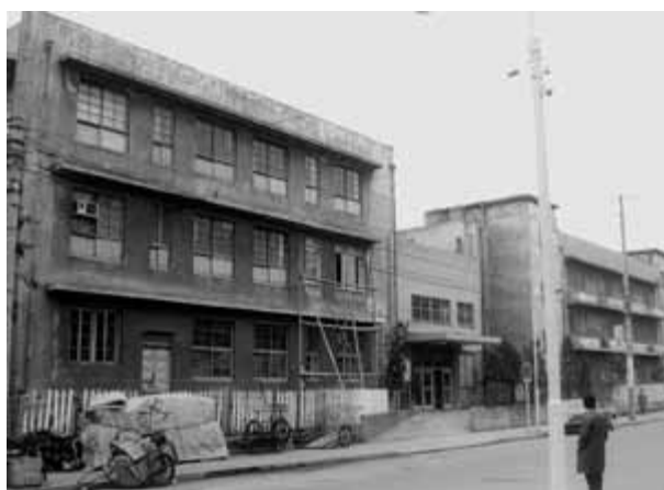
焼け残った病理棟㊦と看護婦寮宿舎㊧
