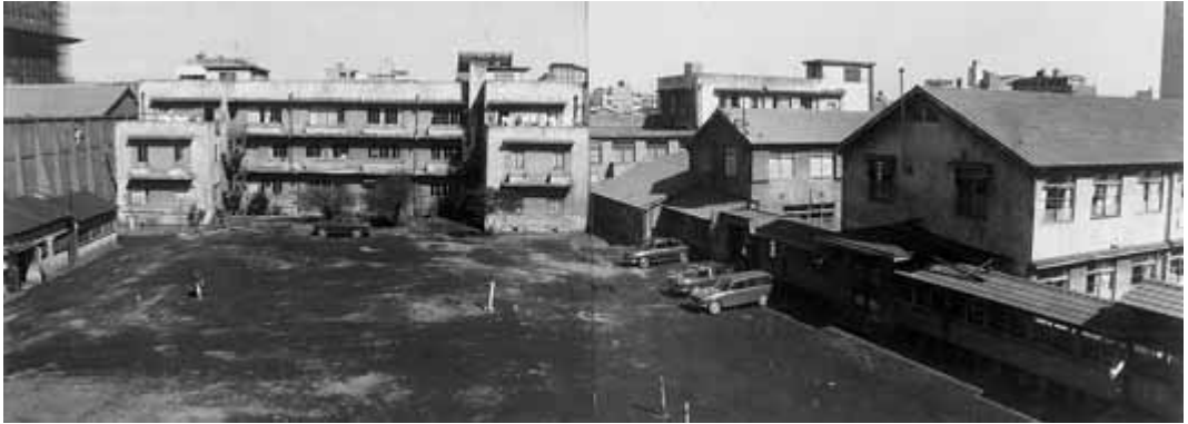
左から本館・2号館、食堂、3号館（新館側から撮影）
